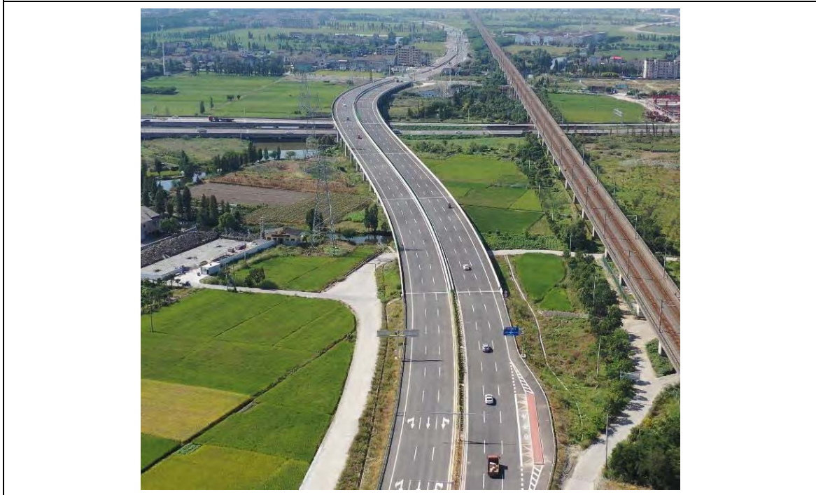
跨绕西南高架桥 (2020. 09)
