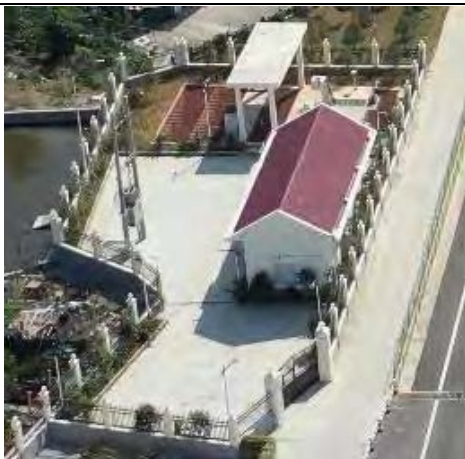
U 型槽管理房 (2020.09)
