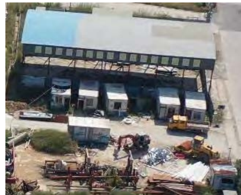
钢筋棚等临建设施 (2020.09)
