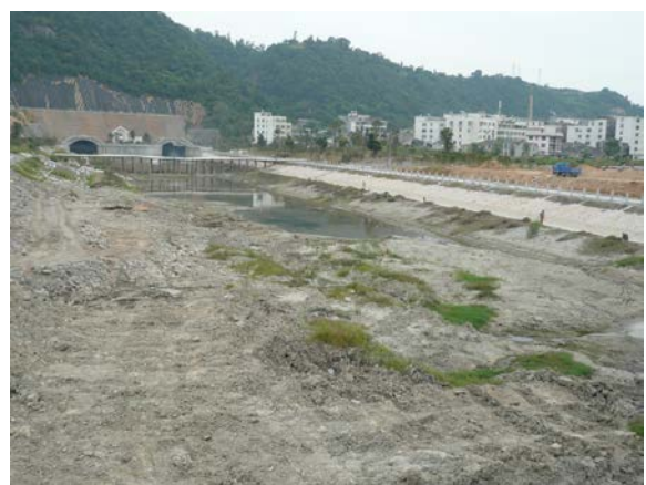
梅屿大河（隧洞至温巨公路桥）（2011.09）
