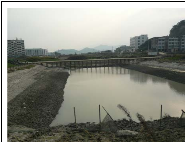
梅屿大河（隧洞至温巨公路桥）（2010.10）
