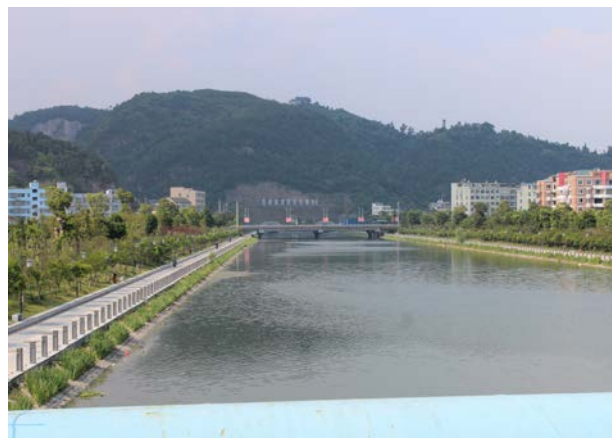
梅屿大河（隧洞至温巨公路桥）（2013.06）
